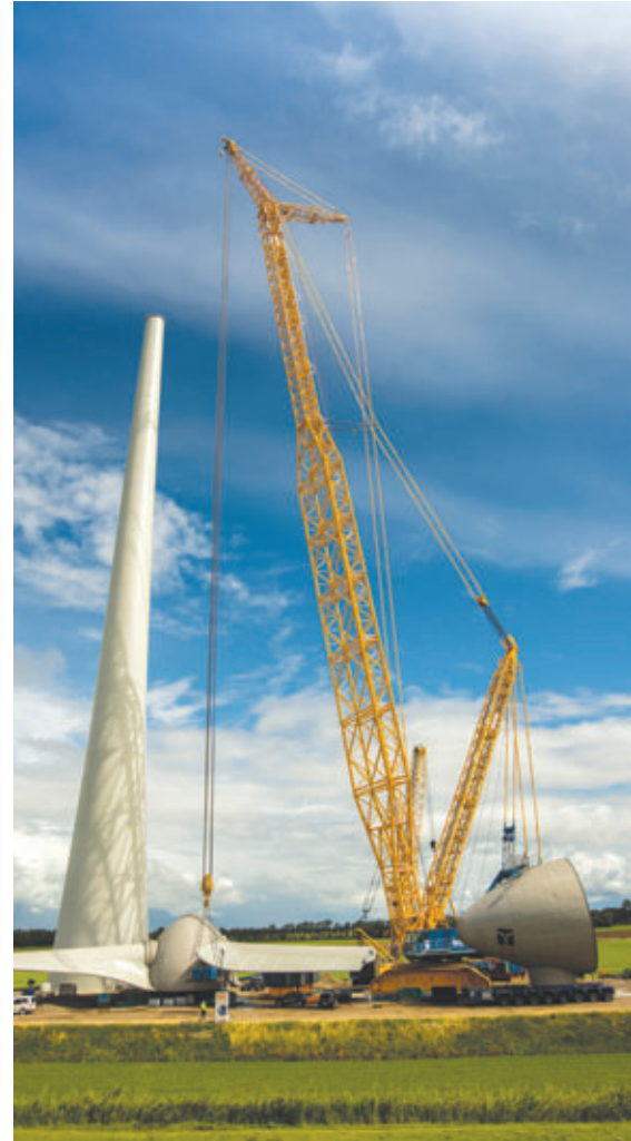
Yüz yetmiş ton ağırlığındaki jeneratör dairesi, 40 m yarıçapta kaldırıldı
