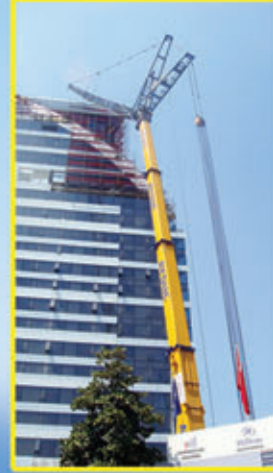
Hilton Otel'de 100m'ye cam silme vinci montajı
