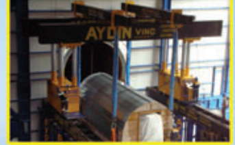
Gantry Sistemle 8m kaideye Siemens Generator montajı
