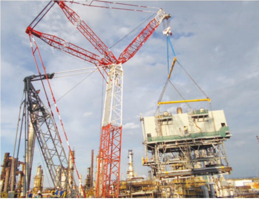
Manitowoc 999, ağırlığı 261,7 ton olan yeni yoğunlaştırıcıyı yerleştiriyor. Paletli vince, bu işlem için yaklaşık 270 ton süperlift denge ağırlığı takıldı
