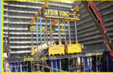
Gantry Sistemle 450 Ton TMB'nin Tünelden Çıkarılması
