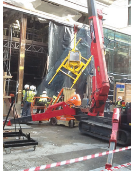
Hydraulica 2600, geçtiğimiz günlerde, 6 ton kapasiteli bir Unic URW-706 ayaklı mini vinçle birlikte, İngiltere'nin başkenti Londra'daki bir cam montaj projesinde kullanıldı. Binanın resepsiyon alanını oluşturan, 7 m yüksekliğindeki panellerin her biri 2,1 ton ağırlığındaydı. Hydraulica'nın 210 derece dönme ve 90 derece yatma yeteneği, elle asgari düzeyde müdahale gerektirerek, büyük yüklerin hassas bir şekilde yönlendirilebilmesine ve doğru noktaya yerleştirilebilmesine olanak tanıyor
