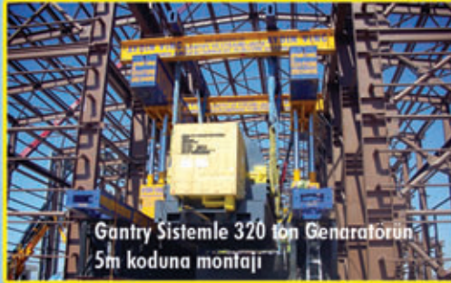
300 ton Siemens Genaratörün nakliyesi
