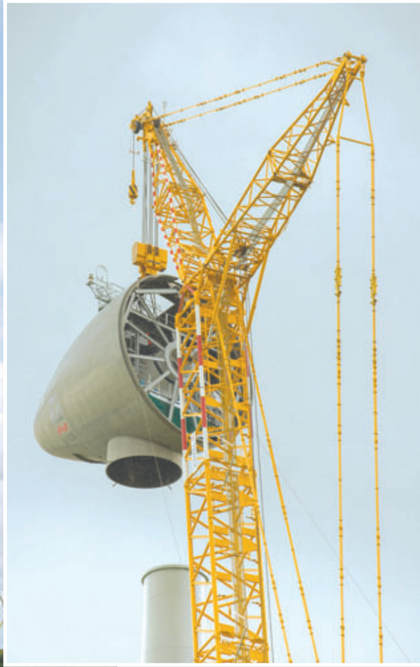
Türbin kuleleri monte edildikten sonra, CC 8800-1 devreye girdi ve türbinin kalan parçalarını, kulenin üzerinde sırayla yerleştirdi
