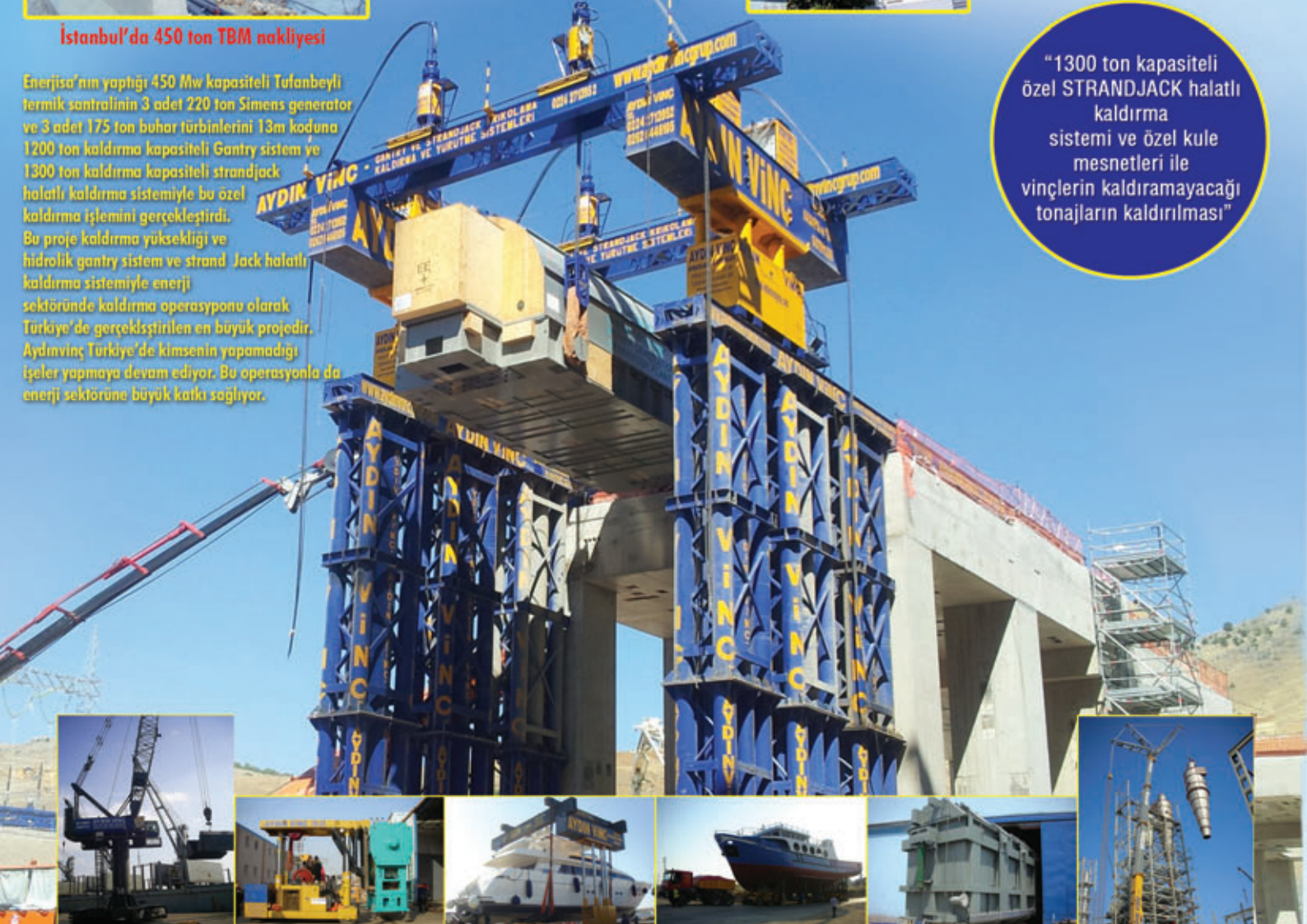
Gantry Sistemle 450 Ton TMB'nin Tünelden Çıkarılması
